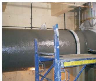
DuraWrap Primer applied.
