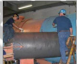
**METALCLAD<sup>®</sup> DuraWrap<sup>®</sup>** puede ser aplicado al interior y/o exterior de tuberías y equipos para sellar y fortalecer estos componentes. Cuando se aplica a las paredes interiores de tuberías subterráneas o inaccesibles, METALCLAD<sup>®</sup> DuraWrap<sup>®</sup> puede reparar y restaurar efectivamente la integridad de las tuberías sin necesidad de una costosa excavación y reemplazo.
