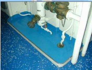
*Calificado para estaciones AFFF y pasillos interiores de alto tráfico en buques de la Armada de los EE. UU. como se detalla en MIL-PRF-32171.*
