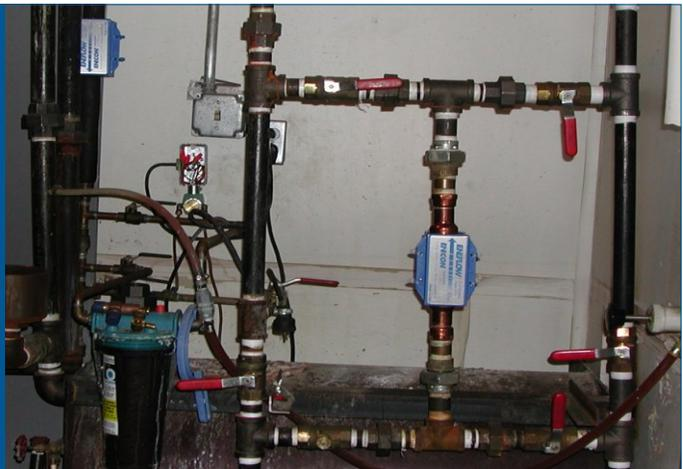
suspensión. Se evita que crezcan tanto que se puedan precipitar fuera de la solución y formar escama dura en las murallas de tuberías y equipo. Este proceso se llama "homogenización magnética."
