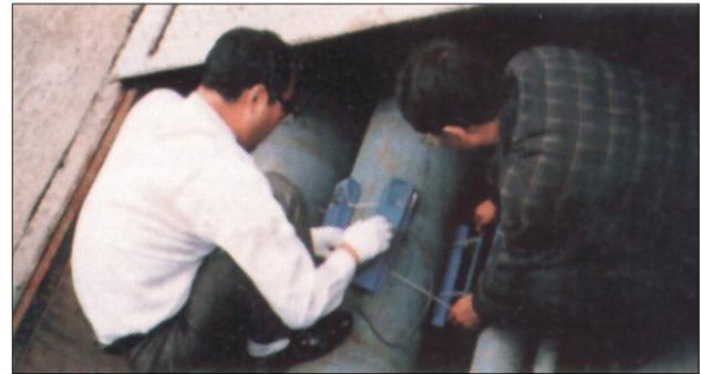
Cuatro pares de células de poder dinámico de fluido ENEFLOW están siendo instaladas en una de las principales (14 pulgadas) líneas de lodo de cenizas
