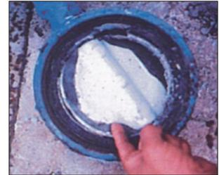
Acumulación de escamas de carbonato de calcio duras es un problema de mantención constante, especialmente en válvulas como se ve aquí.
